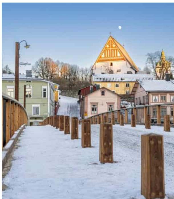
Kuva 7. Porvoon vanha silta on puupalkinto 2026 ehdokkaana.
