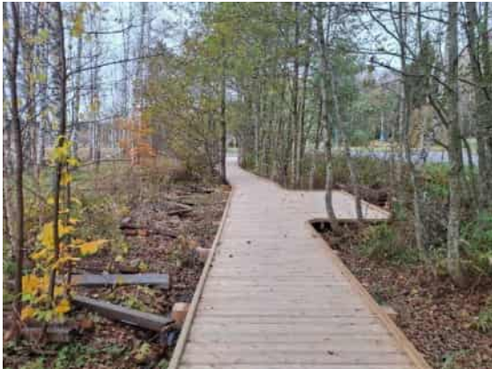
Kuva 14. Pitkospuut korvattiin esteettömällä lankkupolulla.
