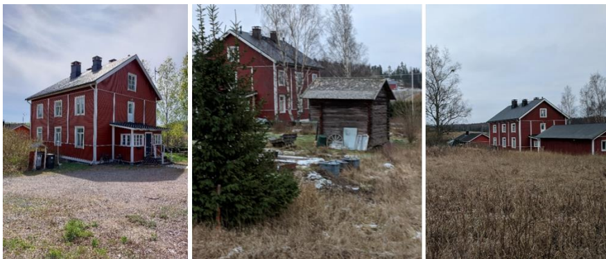
Kuva 14 Töyrytien rakennettua ympäristöä vanhan rautatien läheisyydessä
