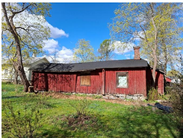
Bild 14. På vänstra delen av sidobyggnaden fanns det tidigare djurstall. I bakgrunden syns lokaler som tidigare fungerat som gästgiveri, bagarstuga och bostad.
