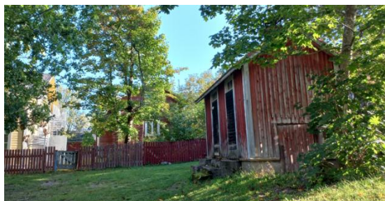
Bild 18. Den lilla sidobyggnaden finns inte i registret. Arean är 12 m 2 .
