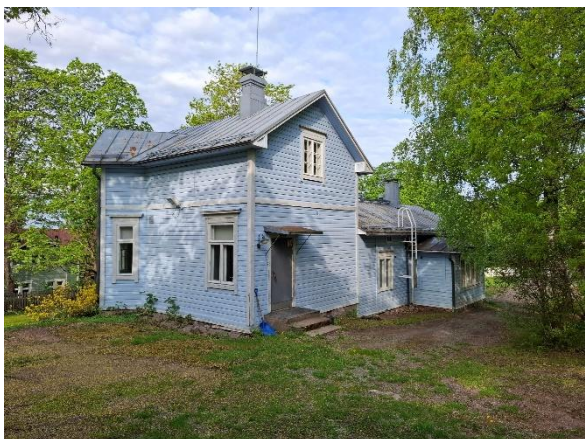
Bild 17. Den blåa daghemsbyggnaden i riktning från öster, från utbyggnadsdelen.
