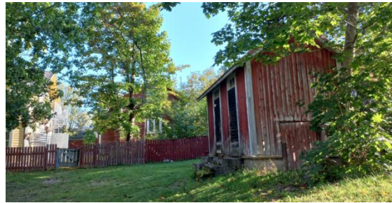
Kuva 20. Pieni sivurakennus ei ole rekisterissä. Sen pinta-ala on 12 m 2 .
