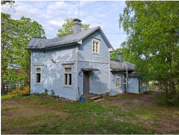
Kuva 19. Sininen päiväkotirakennus idästä, laajennusosan puolelta.
