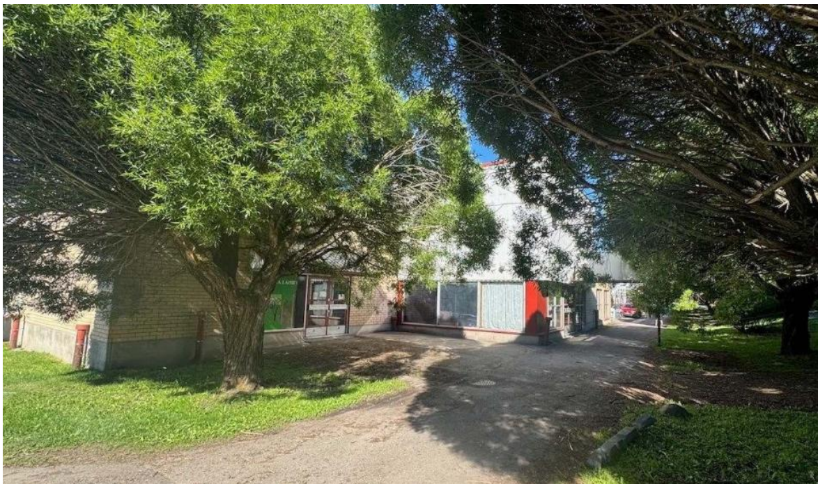
Bild: Fasaden på Gammelbacka affärscentrum (välfärdscentret) och klotpilarna
