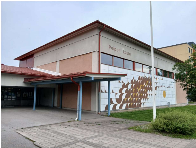
Kuva: Peipon koulun julkisivu
