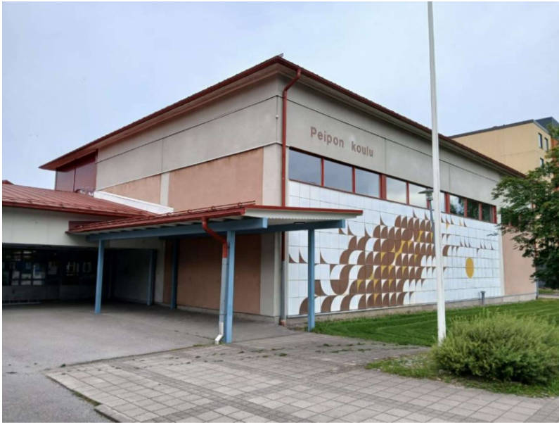
Kuva: Peipon koulun julkisivu
