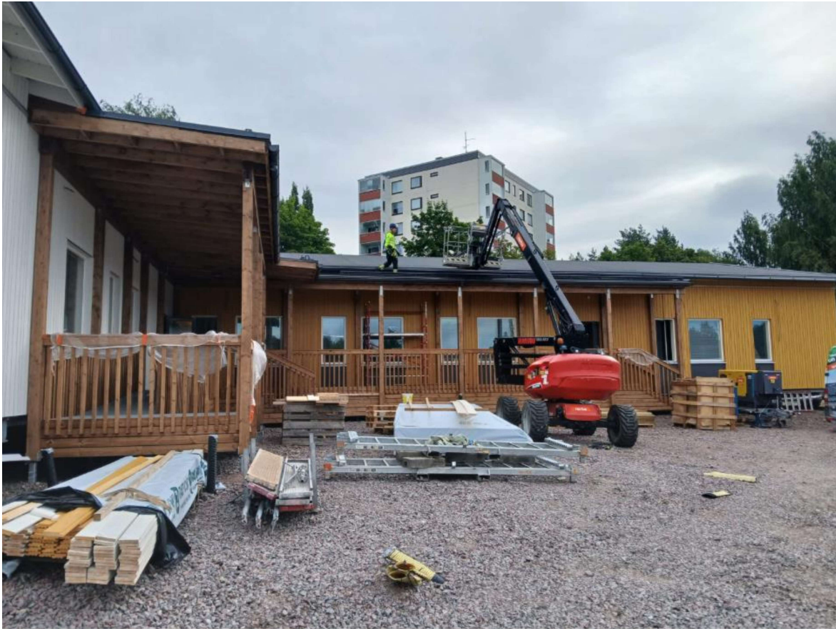
Kuva: Gammelbackan kirjaston ja nuorisotila Kertsin väliaikaiset tilat rakennusvaiheessa elokuussa 2026
