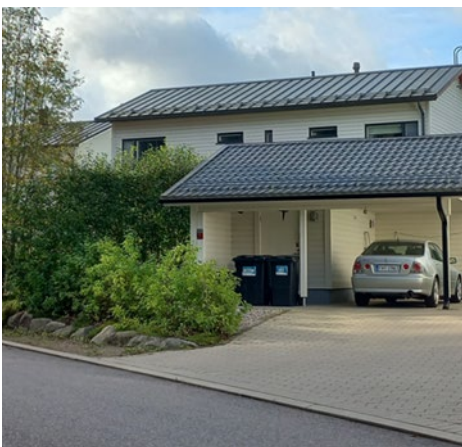
5 Köranslutning och täckt bilparkering är belagda med betong.
