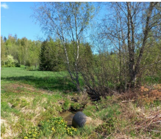
Bild 16. Från gatuområdena i Äppelgården leds dagvattnet genom ett rör till ett öppet dike, som är ett gammalt huvuddike på åkerområdet.
