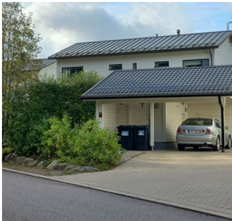
5 Betonikiveystä on ajoliittymässä ja autokatoksessa.
