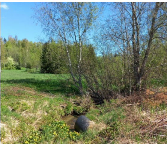
Kuva 16. Omenatarhan katualueilta johdetaan hulevedet putkella avo-ojaan, joka on vanha peltoalueen valtaoja.
