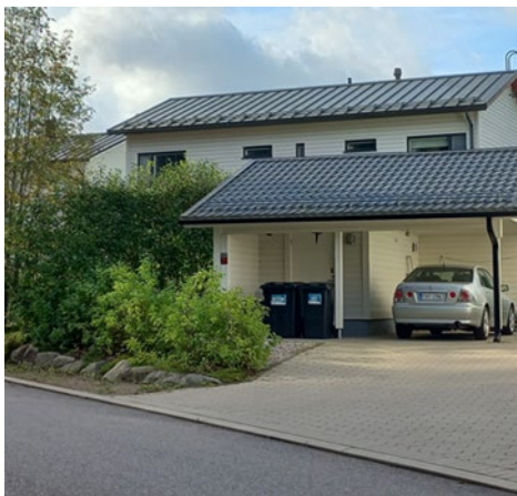
5 Betonikiveystä on ajoliittymässä ja autokatoksessa.
