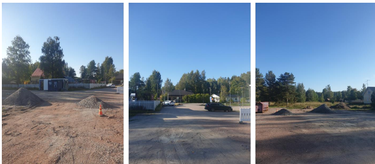
Kuva 8. Kaupunkiomisteinen alue Rengastiellä, josta purettu palveluasumisen rakennuksia
