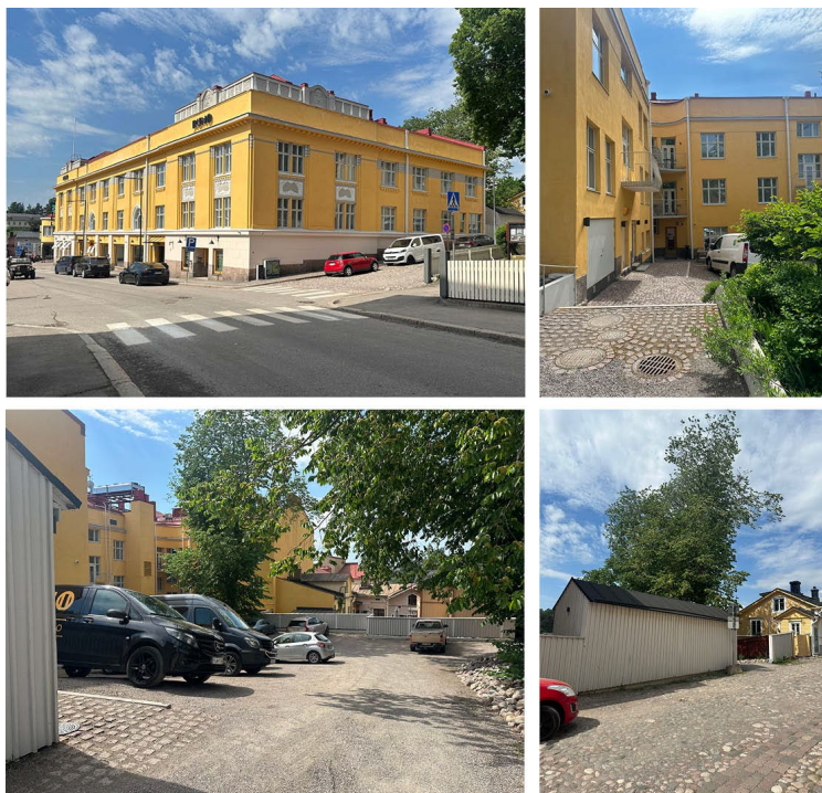
Valtimohuset, nuvarande hotell Runo. Gården är delvis stenbelagd och delvis av stenmjöl. Längs Berggatan finns en liten ny byggnad som fungerar som avfallstak.
