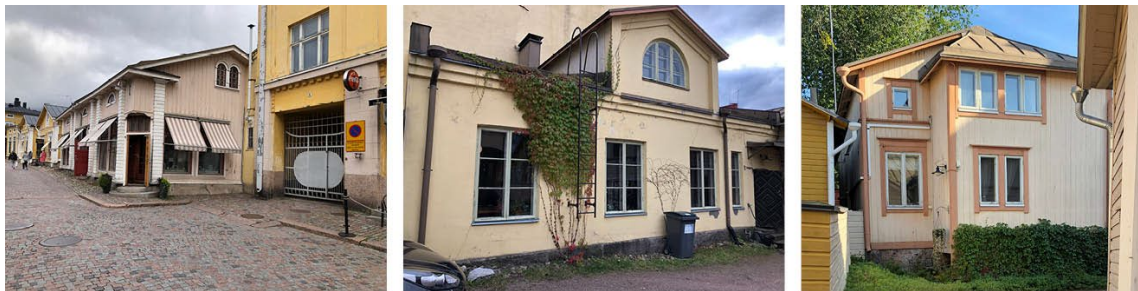
Så kallade Kultakulmas byggnader på tomt 2. Butiken på Mellangatan, i mitten finns gårdens stenkonstruktion och till höger en timrad bostadsbyggnad.
