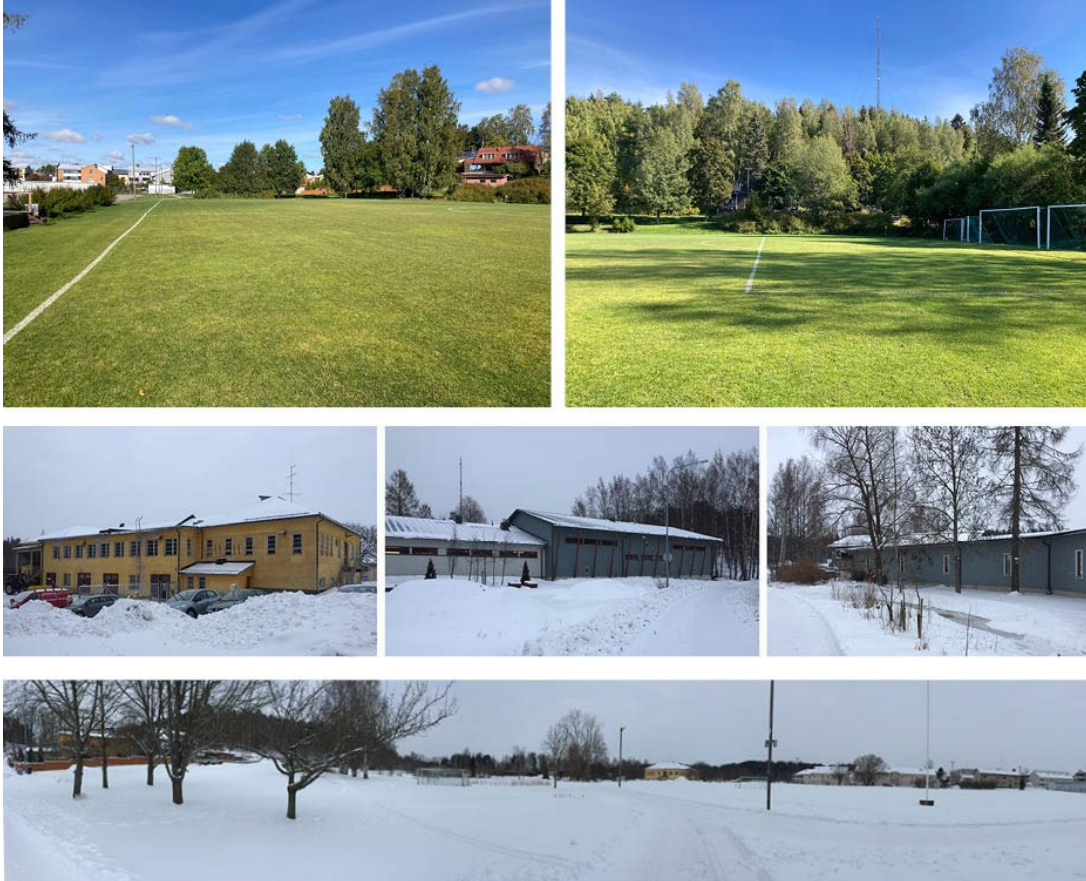
Ylärivissä maisemaa pallokentän ympärillä. Keskellä Suistohalli, uudempi varikkorakennus ja varikon katos puiston reunalla. Alarivissä alueen avointa maisematilaa.
