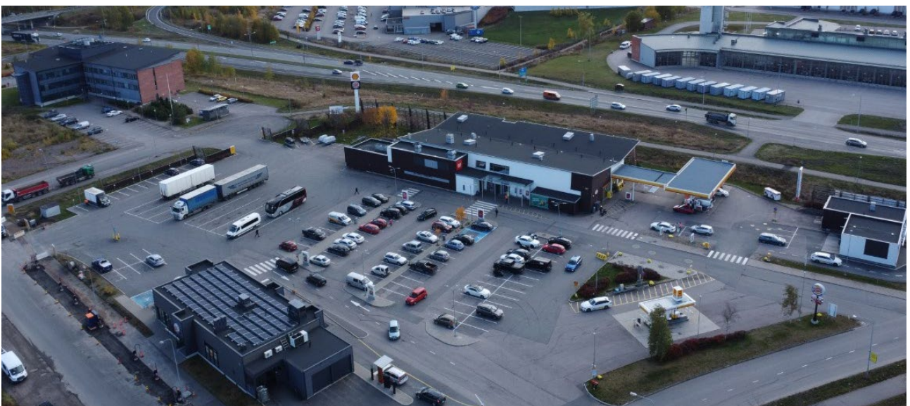
Kuva 5 Viistoilmakuva liikenneasemasta ja toimistorakennuksesta suunnittelualueella.
