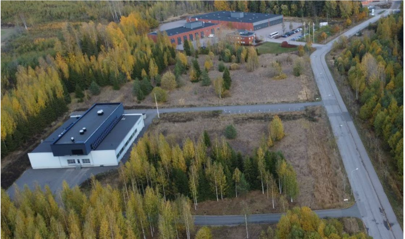
Kuva 4 Laitoskeittiö ja joukkoliikennevarikko viistoilmakuvassa
