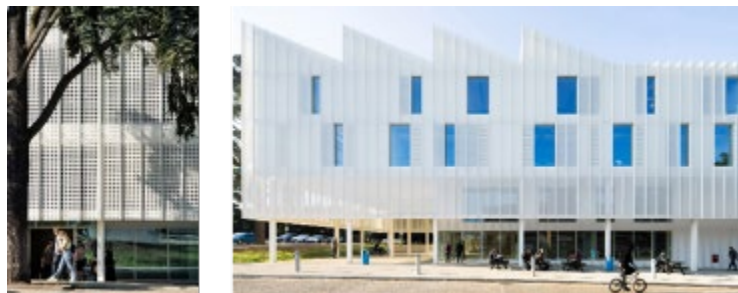
Kuva 4. Perforoitu levy –periaate, jossa liitokset on taitettu ulospäin, mikä luo varjoja ja syvyyttä julkisivuun (Digi-Tech Factory / Coffey Architects).
