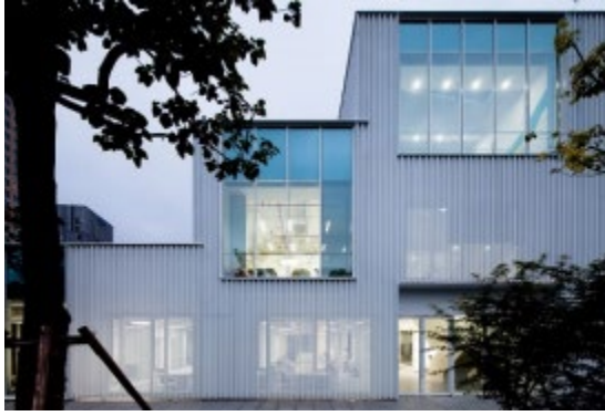
Kuva 6. Perforoitu alumiinilevy, jossa on sekä läpikuultavia että umpiosia. Aaltoileva pelti luo syvyyssvaihtelua sekä pehmentää rakennusta (Schmidt Hammer Lassen, Shanghai office block).
