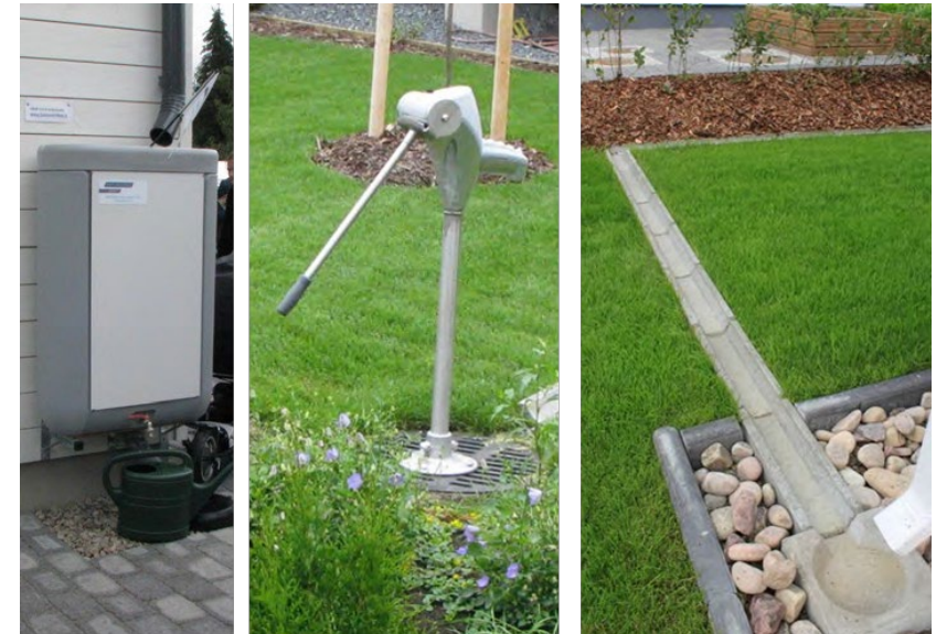
Kuva 16. Hulevesiä voidaan kerätä kasteluvedeksi erilaisin järjestelmin, tai ohjata suoraan pensaiden käyttöön.
