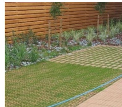
Kuva 18. Nurmikiveys pysäköintipaikalla. Pintaa pitkin valuva vesi ohjataan reunan kasveille.
