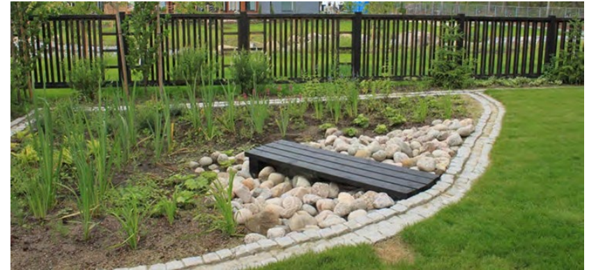
Kuva 15. Hulevesien käsittelyä varten rakennettu istutettu sadepuutarha.
