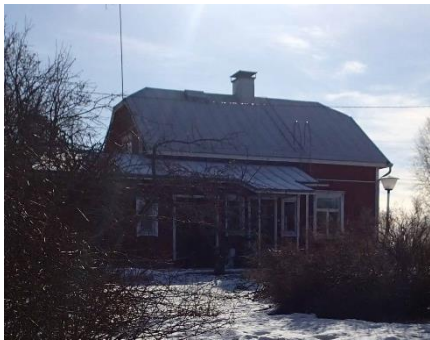
Bild 9 Verandan har byggts ut för våtrum.
