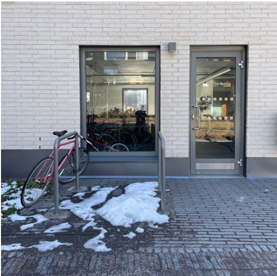
Kuva 4 Polkupyörävarastosta tulee olla käynti suoraan ulos. Sisäänkäyntien välittömään läheisyyteen sijoitetut pyörätelineet lisäävät pyöräilyn sujuvuutta. Kuvan ovi on liian kapea kuormapyörille. (NEMO arkkitehdit Oy)
