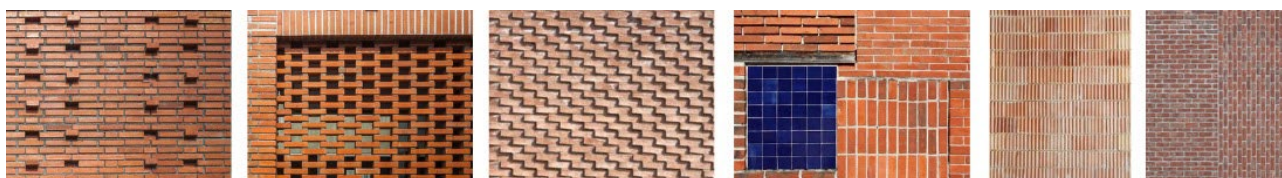
Kuva 20 Kivijalan muuraustapoja. Sisäänkäyntien yhteydessä on mahdollista käyttää pieninä määrinä värillistä lasitettua tiiltä tai tiililaatta.
