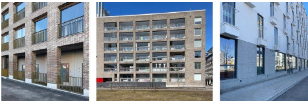
Kuva 40 Vasemmalla ja keskellä keveitä parvekekaiteita lasitetulla parvekkeella. Oikealla syvennetty ranskalainen parveke. (NEMO arkkitehdit Oy)
