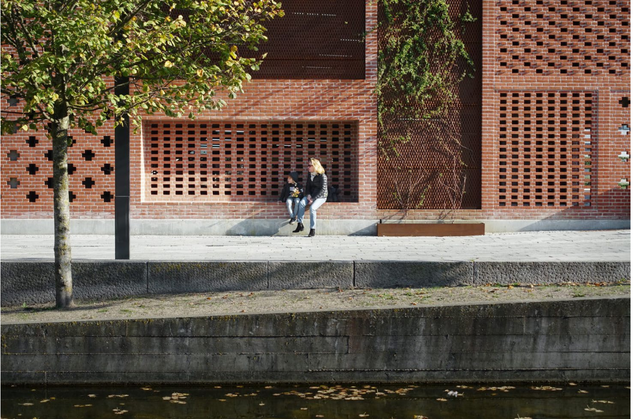
Kuva 24 Hyvä esimerkki erilaisista muuraustavoista ja syvennyksistä kivijalan julkisivussa. Kuvassa julkisivuun upotettu penkki, köynnös ja reliefimuuraus (parkkitalo Ejler Bille Kööpenhaminassa, JaJa Architects 2018)
