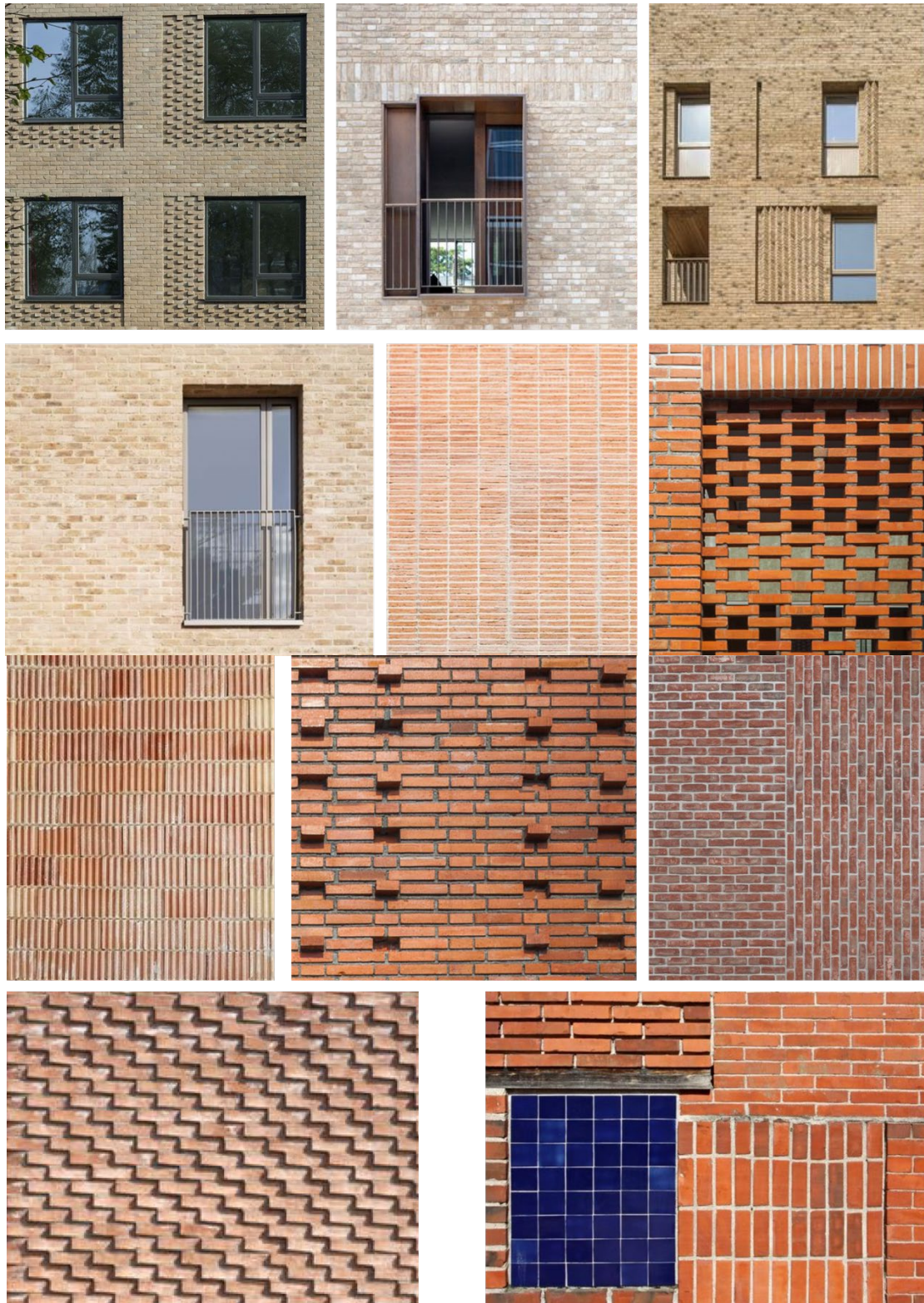
Kuva 14 Tiiliverhoiltujen rakennusten materiaalipaletti: tiilen värit voivat olla hiekan sävyjä, poltetun saven sävyä, harmaata, keltaista, vaaleaa ruskeaa ja punertavaa. Täysin valkoista,
