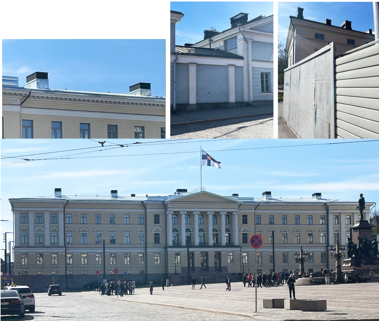
Kuva 37 Referenssikuvia korjauskohteista, joissa uusi kattotekniikka on keskitetty visuaalisesti yhtenäiseksi hormiryhmäksi (NEMO arkkitehdit Oy)
