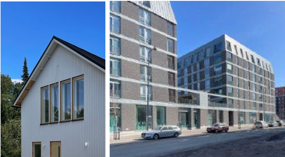
Kuva 35 Puurakennuksissa tulee olla kunnolliset avoräystäät. Mansardikattoisissa rakennuksissa katto liittyy eleettömästi julkisivupintaan. (NEMO arkkitehdit Oy)
