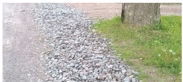
Bild 17. Ytan för infiltreringsremsan vid kanten av körrutten består av kross. Infiltreringen vattnar gräset och trädet.
