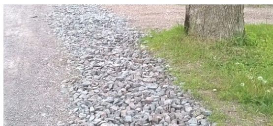
Kuva 17. Ajoreitin reunassa on imeytyskaistan pintana mursketta. Imeytys kastelee nurmikon ja puun.
