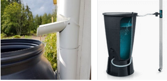
Kuva 4. Ränniin asennettu vesirosvo ja vesiryöstäjä.
