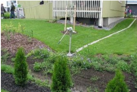
Kuva 6. Vesi on johdettu maanalaiseen säiliöön pihapinnalta betonikivisellä kourulla ja katolta sadevesirännin kautta maanalaisella putkella. Vettä saa nostettua sadevesisäiliöstä käsipumpulla.
