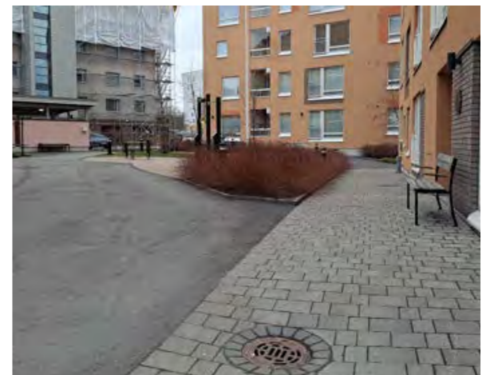
Kuva. Kaikki pihan päällysteet ovat joko asfalttia tai betonikiveystä.
